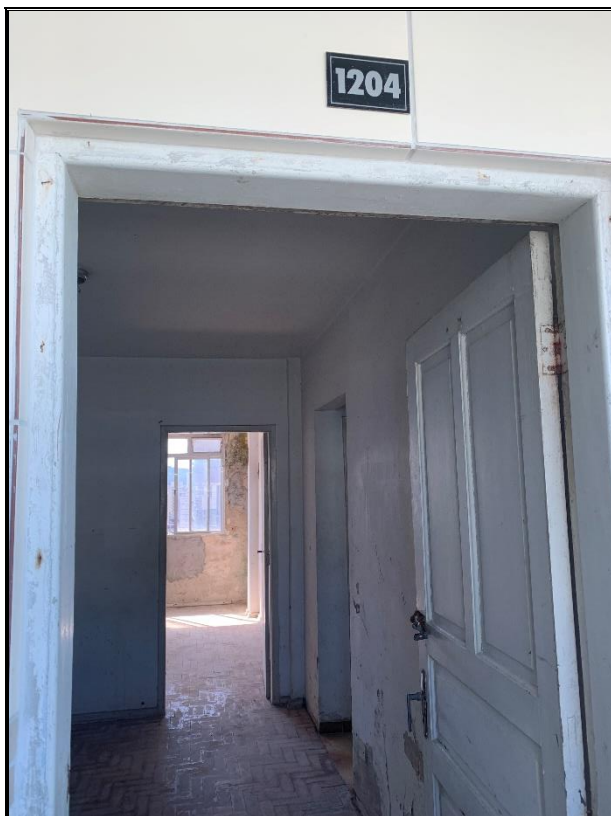
Vista da porta de entrada
